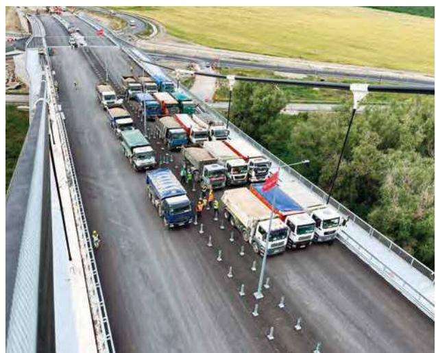
写真-31 静的荷重載荷試験の状況
