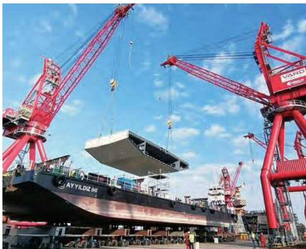
写真-19 ジブクレーンによる相吊り
