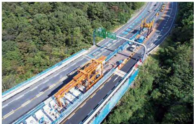
写真-3 床版取替機「EVO」施工状況
