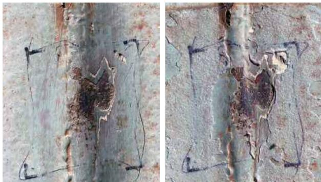
図-9 貼付け型防食部材の貼付け直前と
