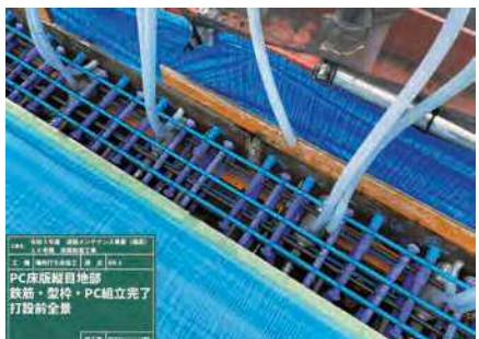
写真-1 橋軸方向接合部の配筋
