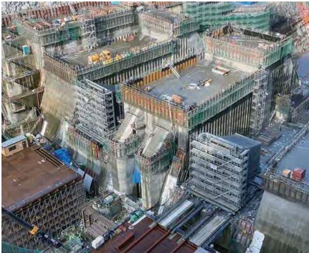
写真-12 放流管引込み完了
