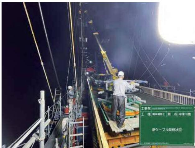
写真-2 ケーブル取替え状況
