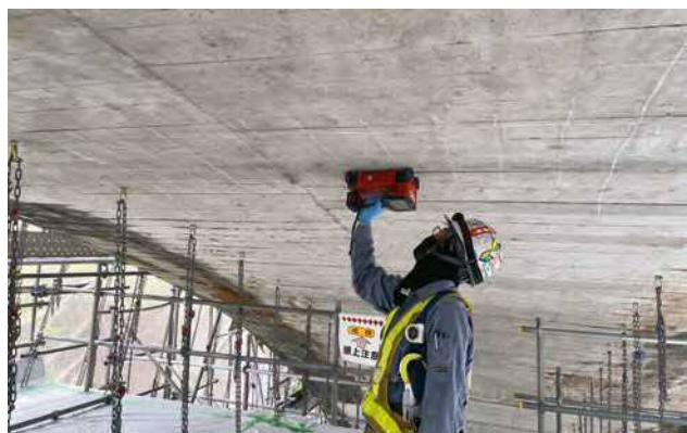
写真-3 アーチリブ鉄筋探査状況
