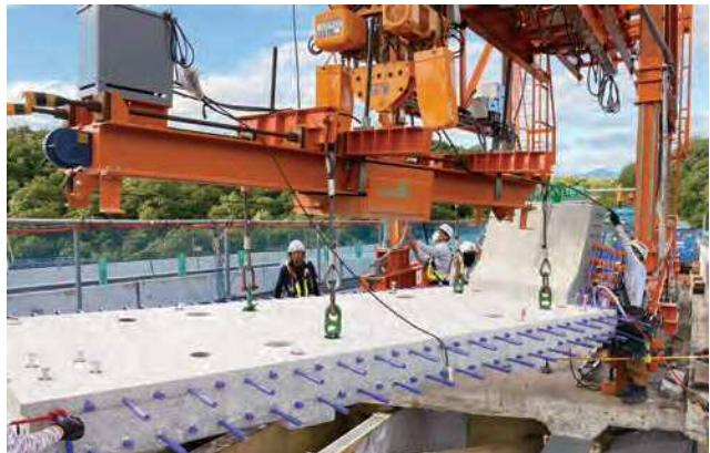
写真-4 床版取替機「EVO」施工状況
