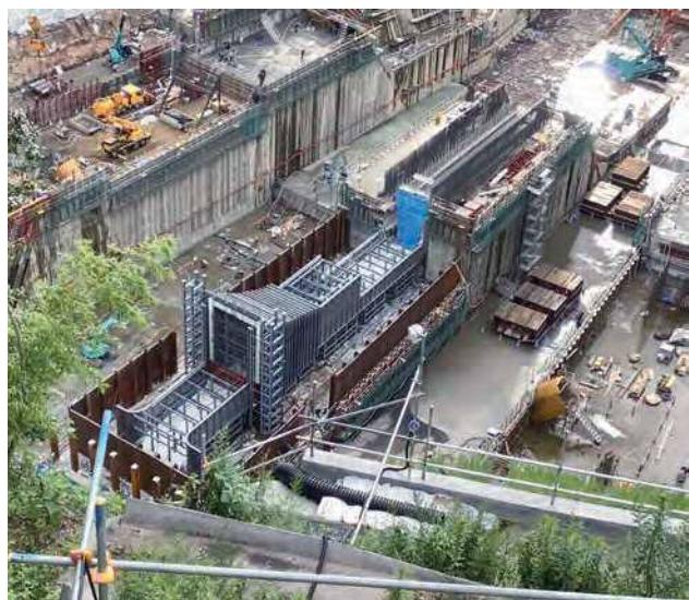
写真-9 放流管、整流板据付完了
