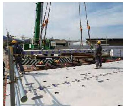
写真-7 クレーンによる床版架設
