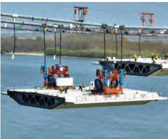
ストランドジャッキによる杭架設
