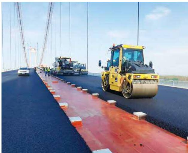
写真-30 補装の施工状況
