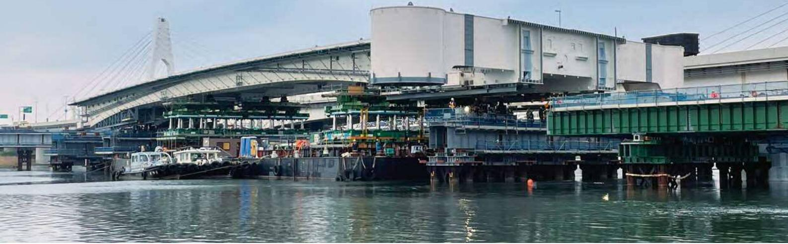
写真-1 台船リフトアップ架設
