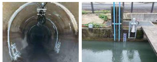
写真-14 超音波流量計(直接)
