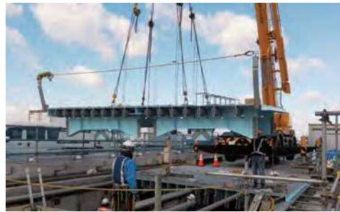
写真-3 鋼床版の架設
