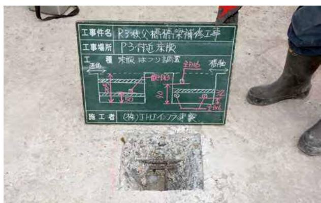
写真-1 上縁部鉄筋確認状況
