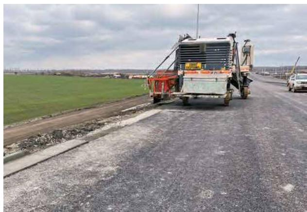
写真-24 路肩部排水溝の連続打設機
