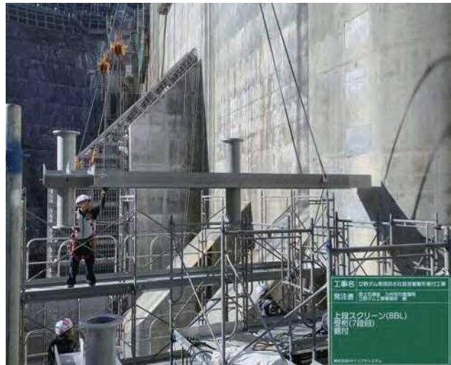
写真-13 受桁据付状況
