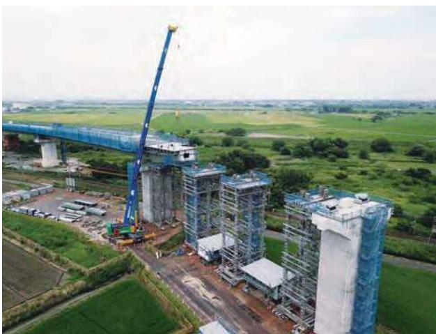
写真-9 側径間部架設状況
