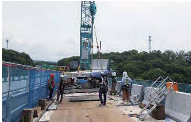
写真-2 クローラクレーン施工状況
