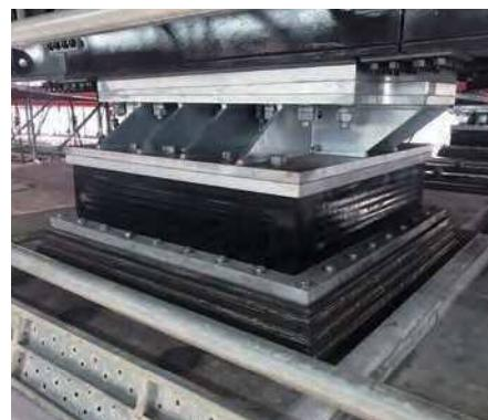
写真-5 新設支承設置状況
