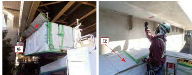
写真-3 高所作業車庇設置状況
