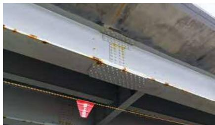
写真-2 添接部やコバ部での鋼材腐食事例
