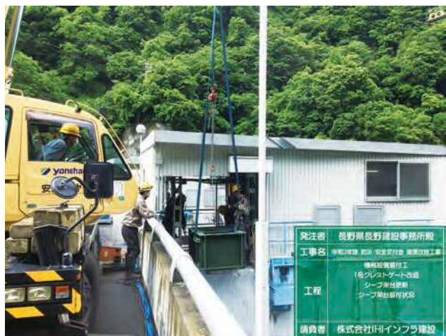
写真-4 シーブブロック据付状況
