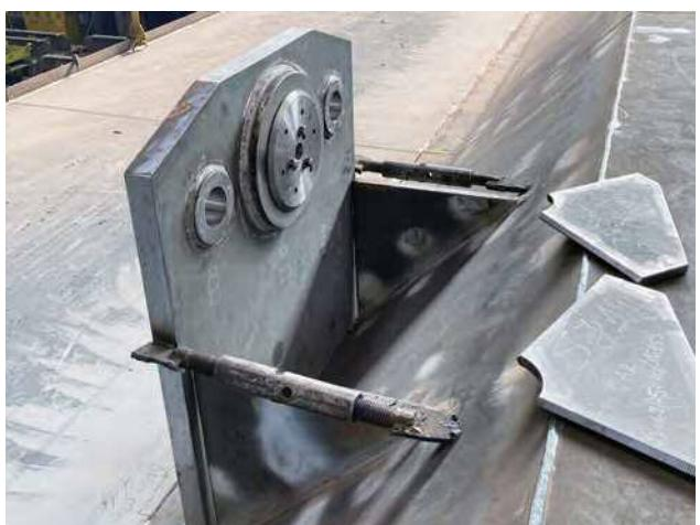
写真-13 ハンガープレート取付け状況
