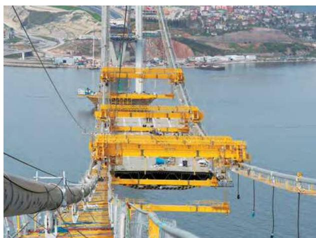
写真-25 オスマン・ガーズィー橋 直下吊り設備
