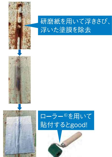
図-8 施工工程
