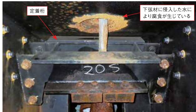
施工時に止水ゴムを撤去し下弦材内部からも見えづらかつたケーブル腐食状況を確認したところ、腐食が空中部よりも酷く、著しい減肉となっていた。下弦材内部の既設ケーブルの様子を図-7に示す。
