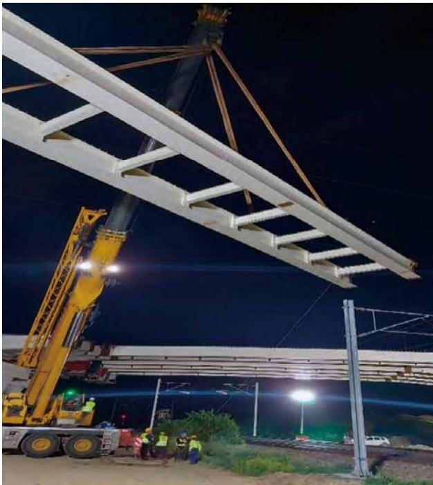
写真-17 跨線橋・桁架設状況
