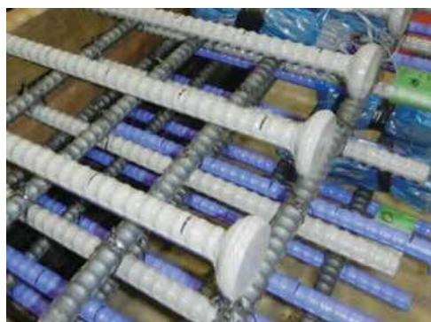
写真-2 Tヘッド工法鉄筋
