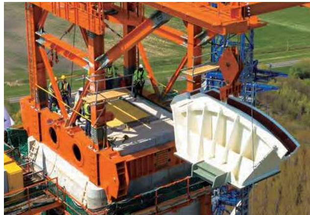
写真-2 塔頂サドル架設状況
