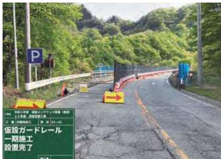
写真-2 仮設ガードレール設置
