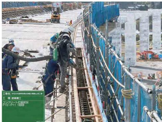
写真-11 壁高欄打設状況
