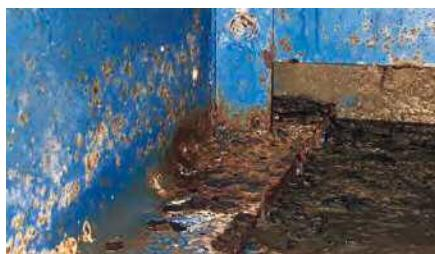
写真-1 桁端部での鋼材腐食事例
