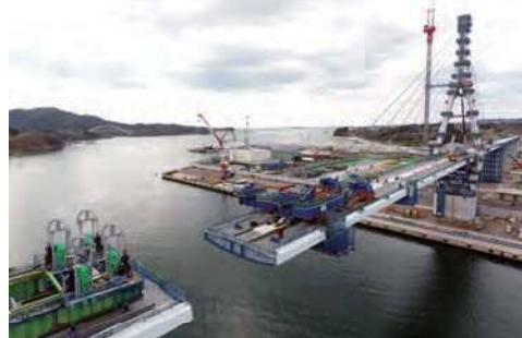
写真-2 桁の架設
