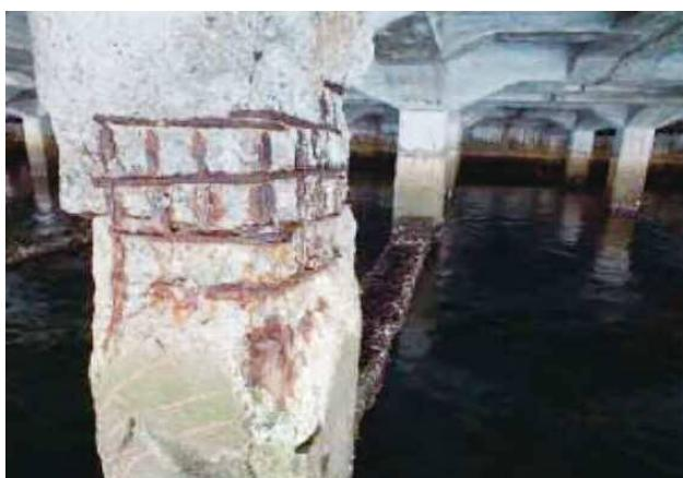
写真-1 桟橋床版下部の損傷事例
