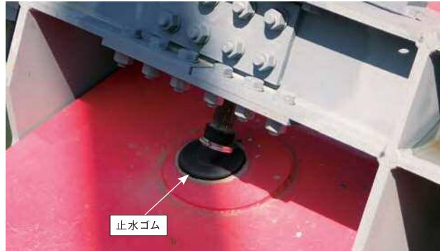
図-5 既設ケーブル下弦材止水状況
