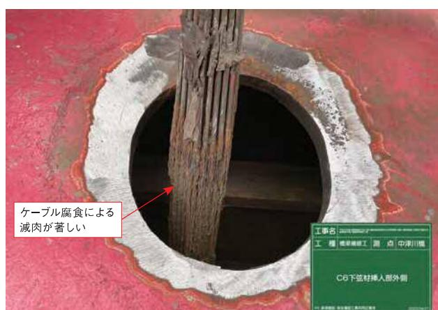
図-7 下弦材内部の既設ケーブル
