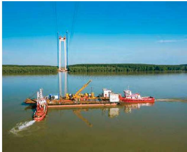
写真-7 CWロープ沈設渡河状況
