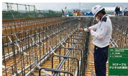
写真-1 PCケーブルTS計測状況
