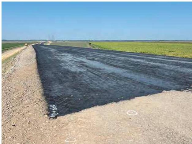
写真-10 アスファルト施工前の瀝青プライマー
