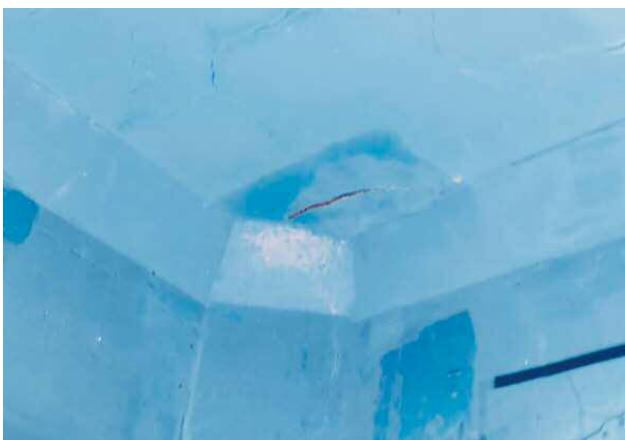
写真-9 ひび割れからの浮きの発見(今回写真)
