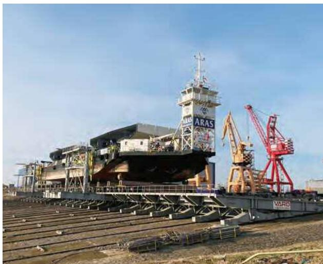
写真-20 昇降装置によるバージ進水
