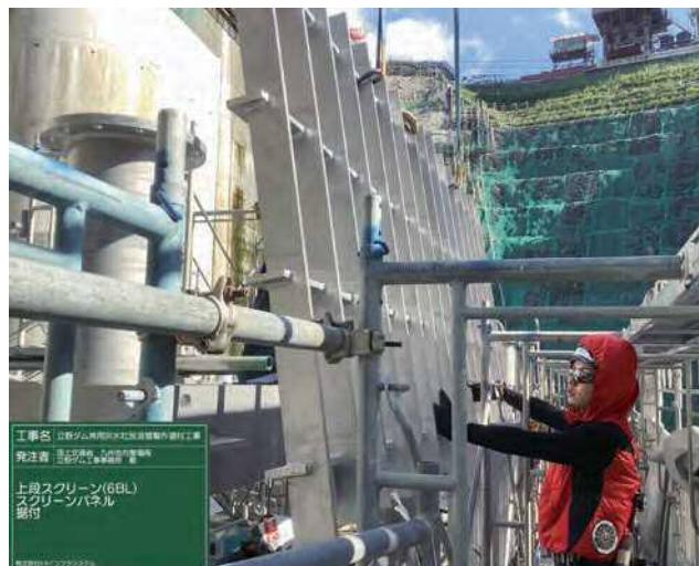
写真-14 スクリーンパネル据付状況
