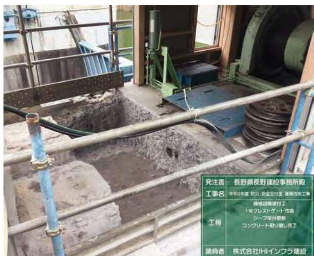
写真-5 コンクリート取壊し完了
